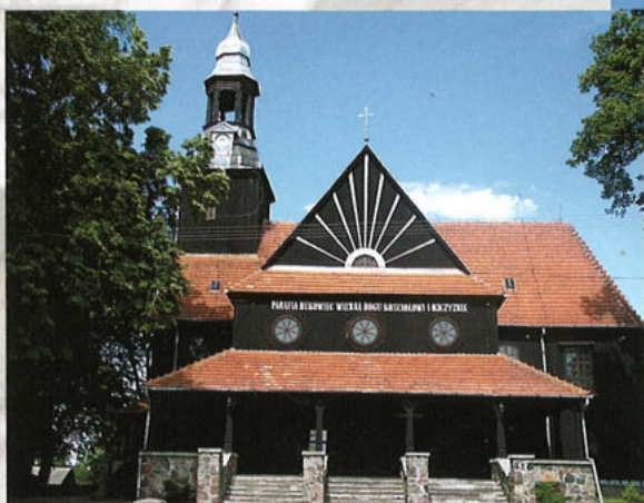
Drewniany kościół w Bukowcu pochodzący z XVIII wiek
