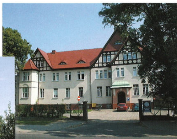
Szpital, którego najstarsza część zbudowana została w 1905 r.
